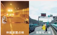
伸縮装置点検
